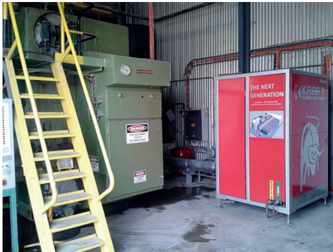
Şekil 3: Kompakt Kraft Curing KC 20 – 1S Buhar Jeneratörü (sağda) kazanın yerini aldı. Kraft buhar jeneratörleri geleneksel kazanlara oranla çok daha az yer kaplayarak aynı performansı sunuyor
